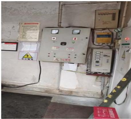
图 18 油罐渗漏检测仪
