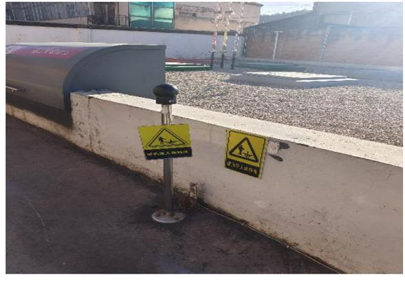
图 15 油罐通气管
