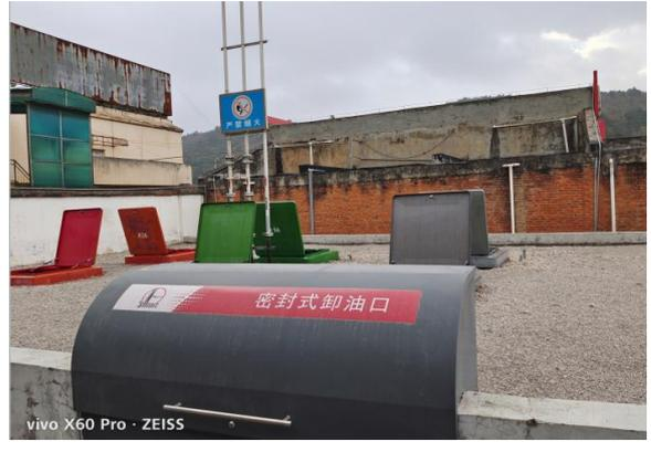
图 11 油罐操作井-汽油罐
