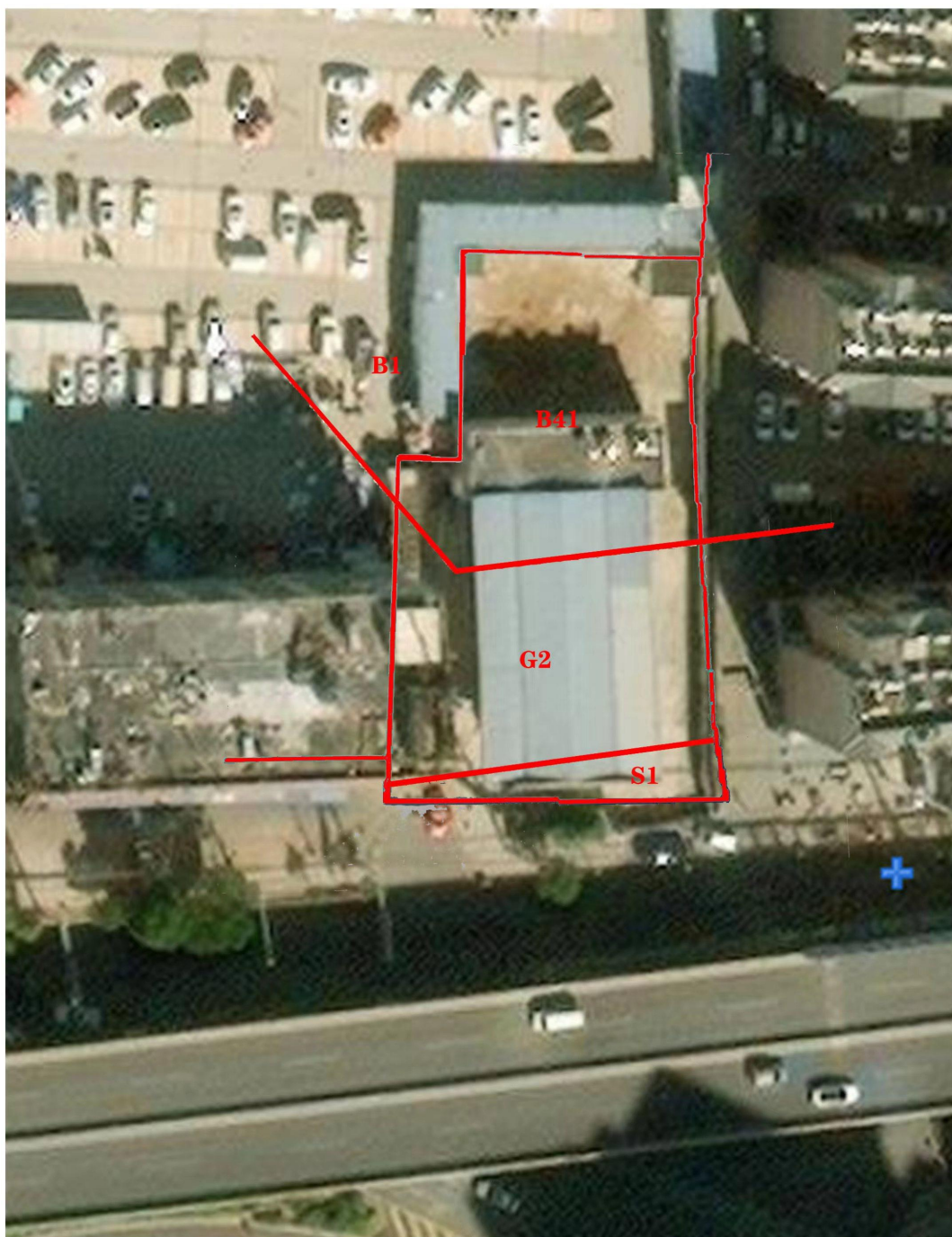
黄土坡加油站卫星影像图
